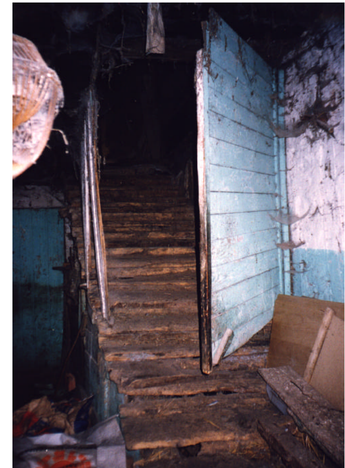
Escaleras de acceso a la planta primera.
