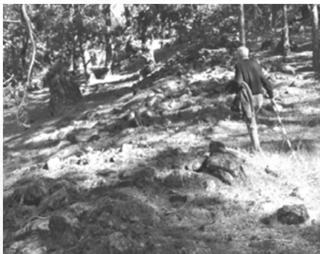
Derrumbe de la muralla de Peña la Mina
