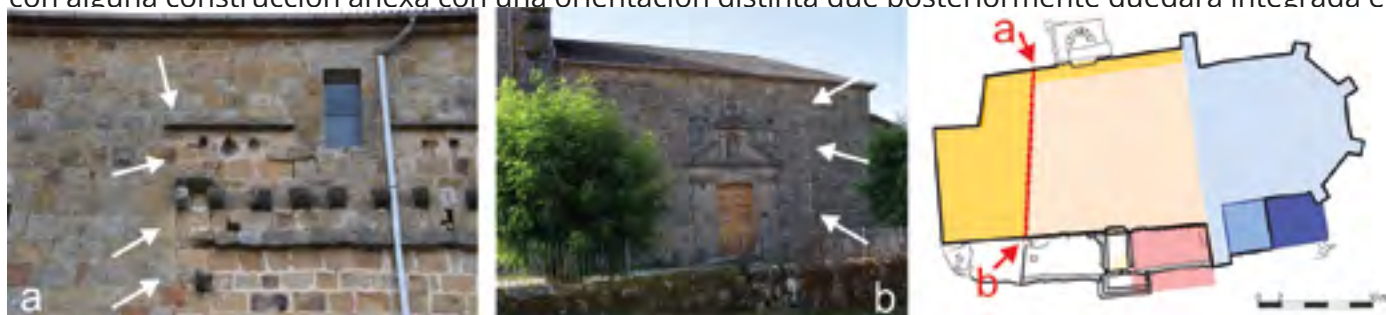
Fig. 2. La fachada sur (a) como la fachada norte (b) muestran un cambio de paramento que parece responder a una construcción antigua de la primera fase del templo. Ambos límites marcan una línea recta que sigue la misma orientación que el límite del vestíbulo anejo a la fachada sur que se observa en la planta.
